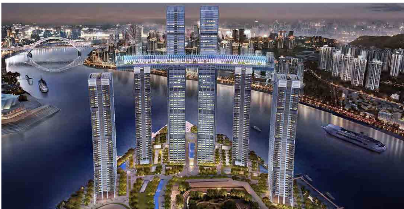
Figure 2. View of Raffles City Chongqing from podium (Source: Safdie Architects) 图2. 自裙楼看到的重庆来福士广场风光 (来源: 萨夫迪建筑师事务所)
