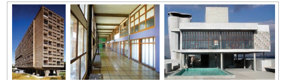
Fig 3. L'Unité d'habitation, Marseilles, France
